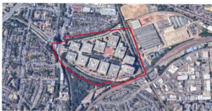
Λονδίνο (Chiswick Business Park)
