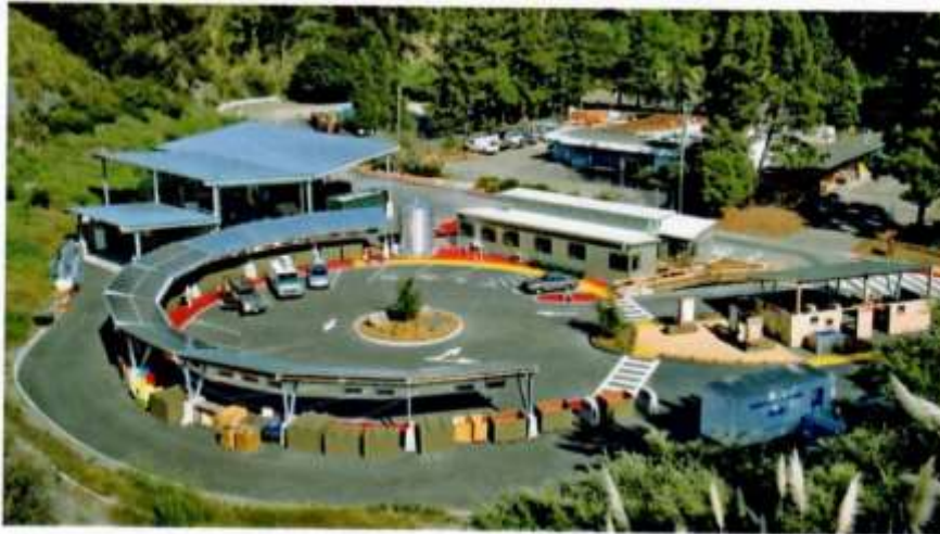
Εικόνα : ΠΣ με πλατεία για την εκφόρτωση και περιμετρική οδό για τη διαχείριση / μεταφορά των υλικών
